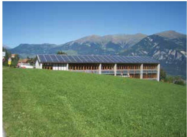
Eine der verkauften Solarstromanlagen: die 31 kW-Anlage auf dem Schulhaus von Flerden, die 2007 in Betrieb ging.
